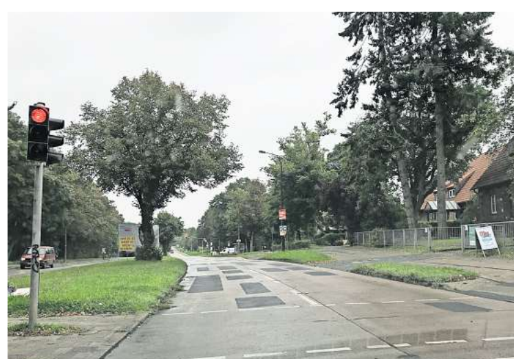
Die Bürgermeister-Haupt-Straße wird vom Wonnemar kommend bis zur Schweriner Straße komplett gesperrt – der Verkehr wird einspurig auf die andere Fahrbahnseite umgeleitet.
